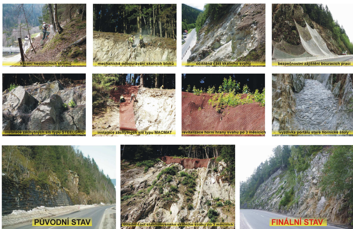
Průběh stabilizačních prací
