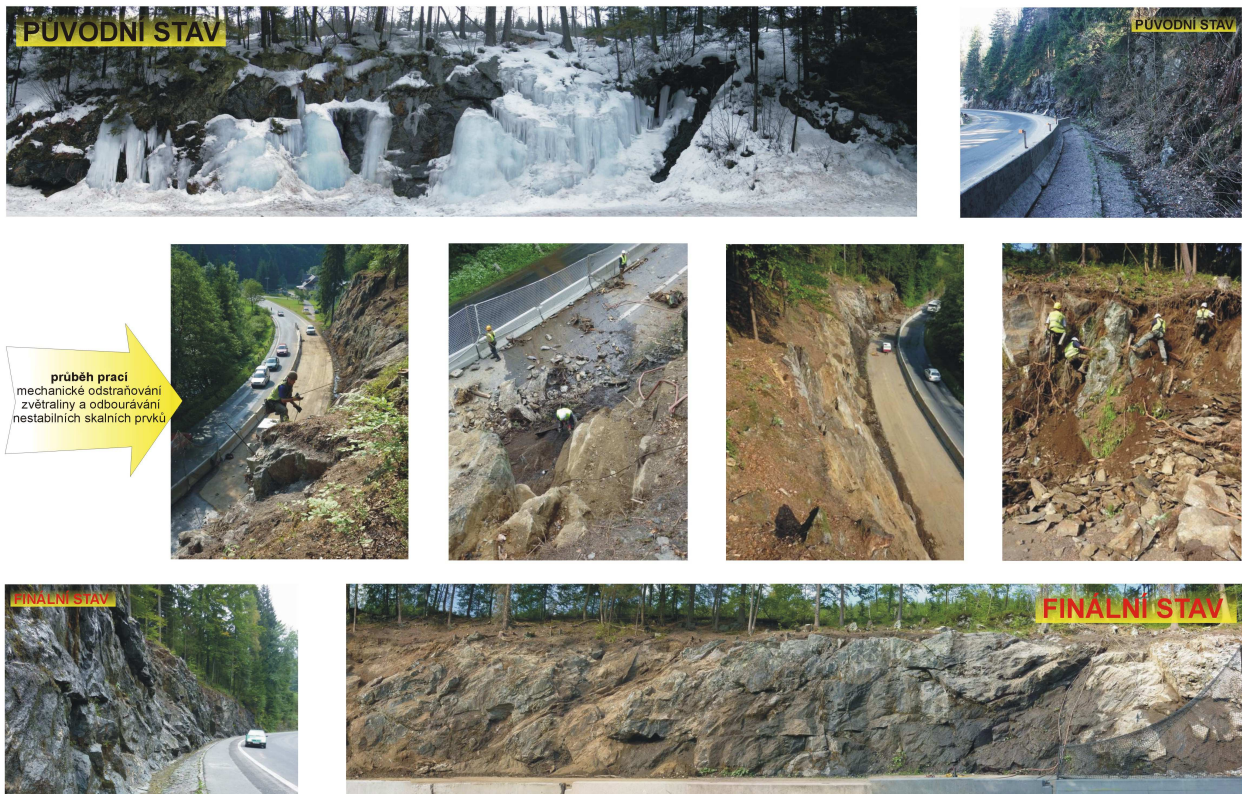
Průběh stabilizačních prací
