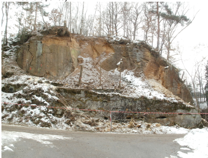
Stavební odkryv na počátku stabilizace svahu (03/2013)
