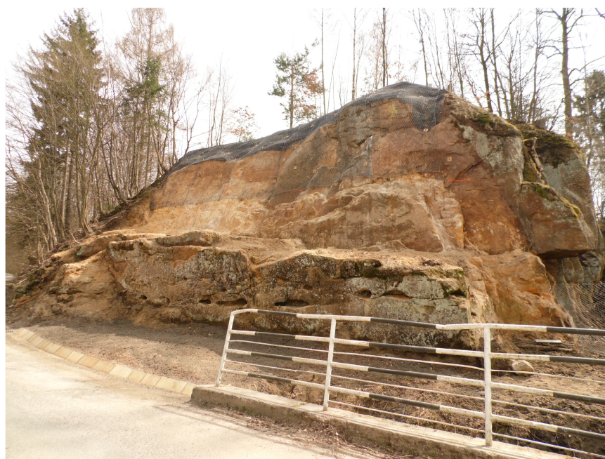
Dokončená stabilizace skalního svahu (04/2013)
