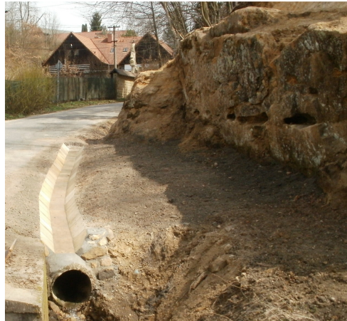
Terénní úpravy a odvodnění v patě svahu (04/2013)
