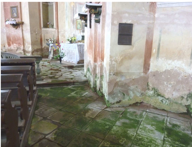
Zamokření podlahy a stěn v interiéru kostela
