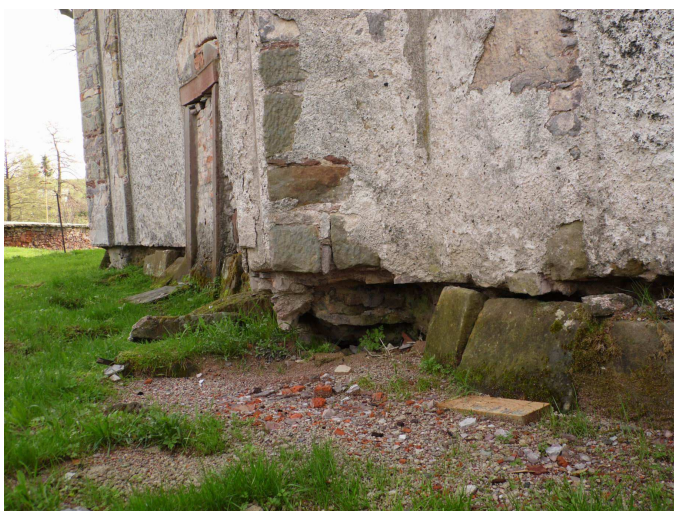
Rozpadlé soklové zdivo v SZ-zdi kostela
