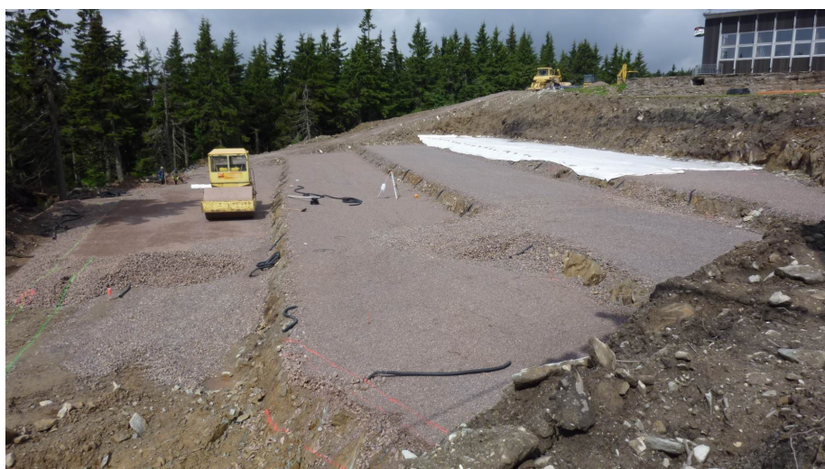
Dokončená úprava základové spáry (06/2011)
