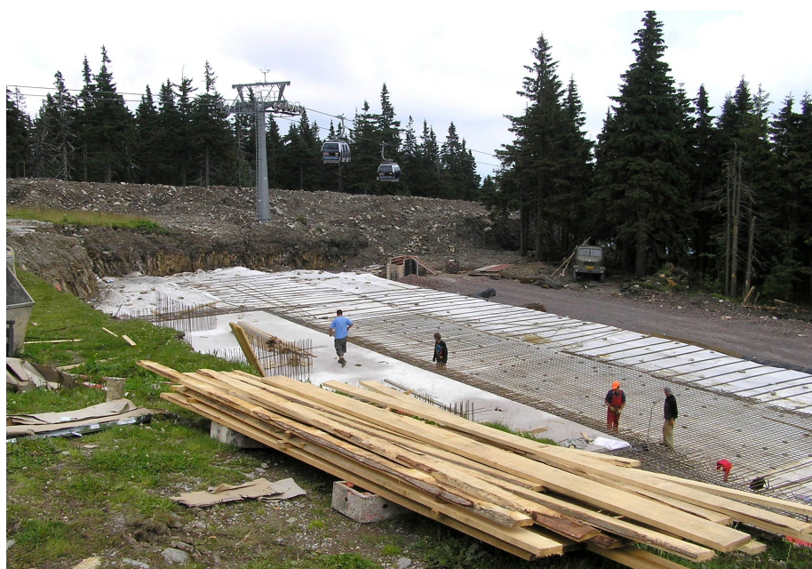
Stavební práce na základové desce retenční nádrže (08/2011)
