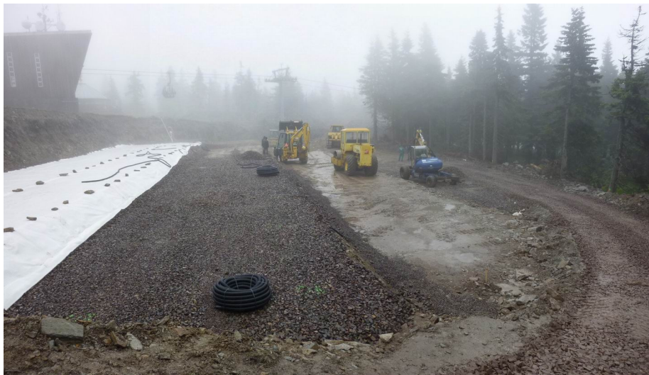
Stavební práce na úpravě základové spáry (06/2011)
