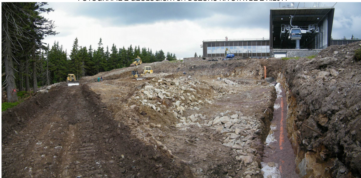
Začátek těžení základové jámy (06/2011)
