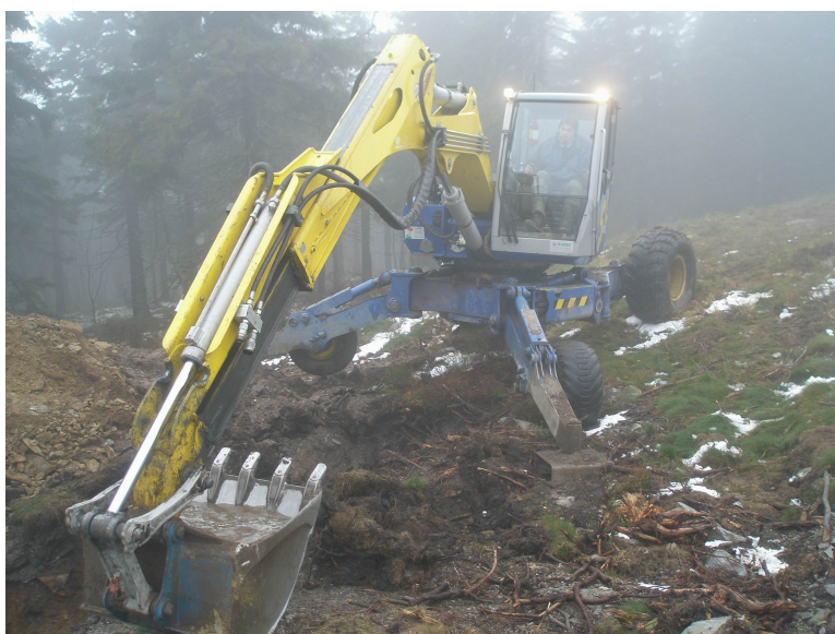
Sondážní práce krácejícím bagrem Kaiser (10/2007)
