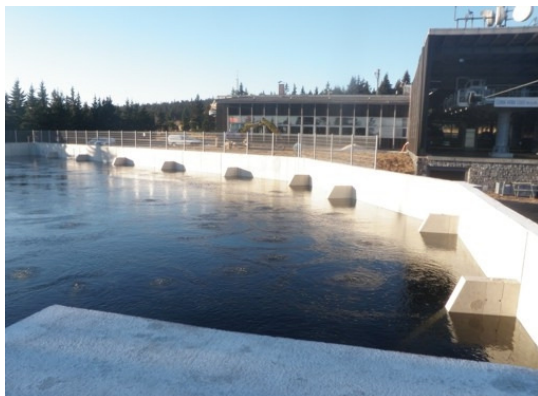
Hotová retenční nádrž
