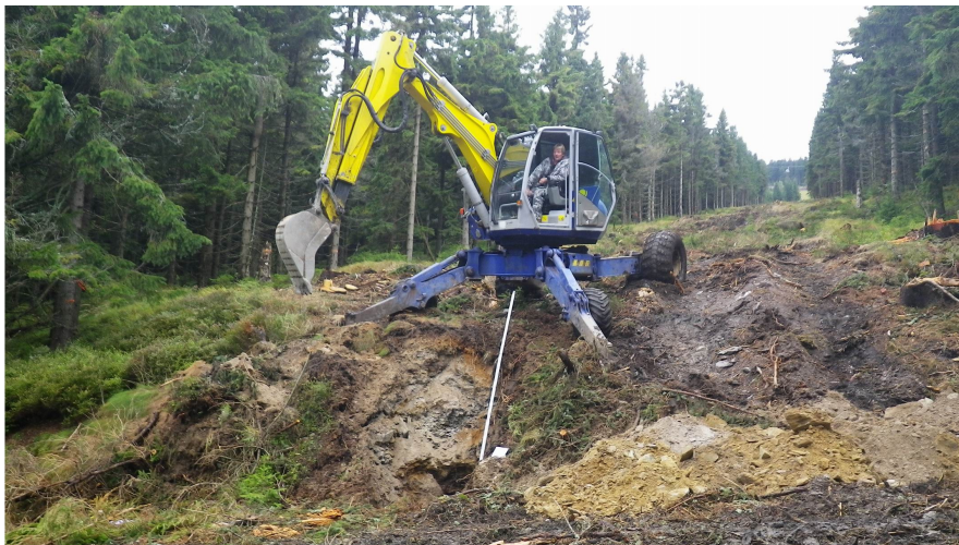
Sondážní práce byly prováděny krácejícím bagrem Kaiser (09/2013)
