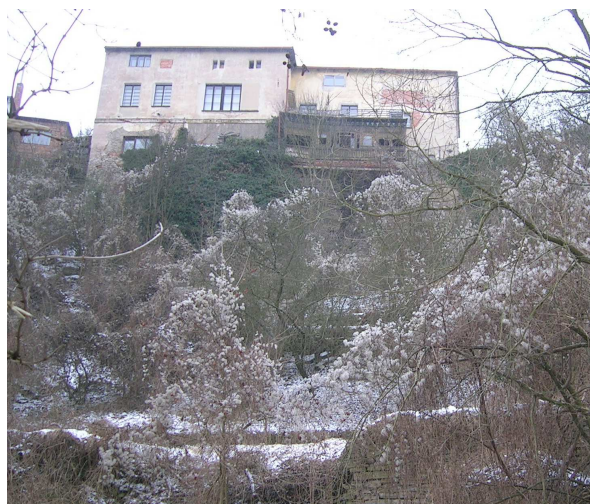
Úsek pod obj. „B“ při pohledu zdola - před stavbou (2010)
