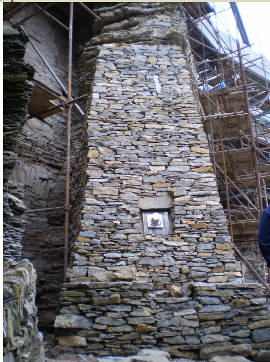
Skalní pilíř P2a a po stabilizaci kotvenou žb vzpěrou s kamennou obezdívkou (2013)
