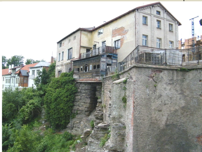
Jižní část pod objektem „B“ před stavbou (2010)
