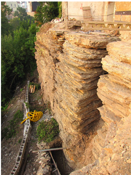
Čištění skalní stěny od zvětraliny (08/2012)
