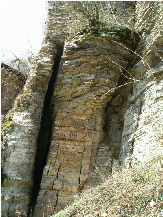
Úsek za obj.„C“ při pohledu zdola - před stavbou (2010)
