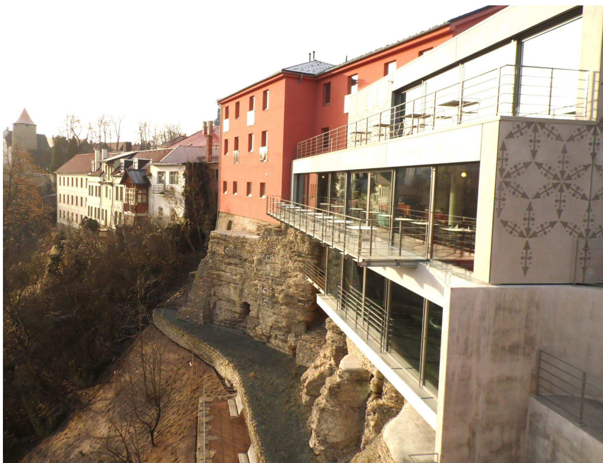
Stavba Wellness hotelu Rajska zahrada včetně stabilizace skalní stěny po dokončení (12/2013)
