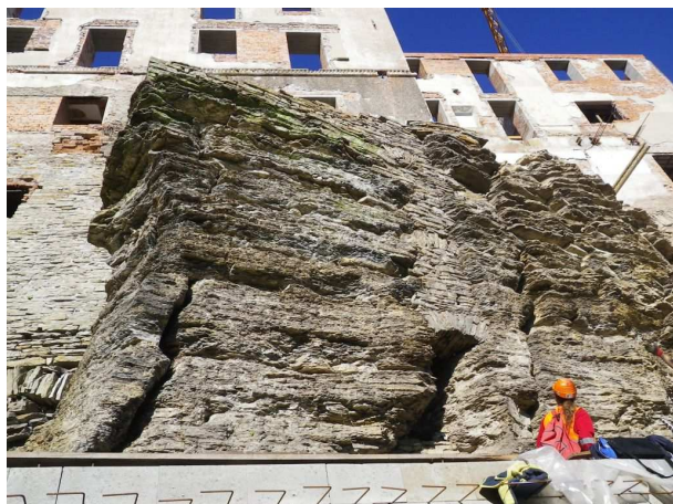
Skalní pilíře P2a, P2b po odbourání nestabilních prvků (08/2012)
