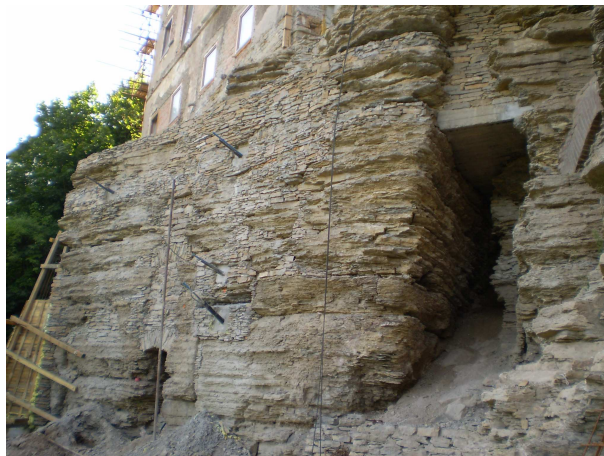
a po stabilizaci kotvením a injektáží (07/2013)
