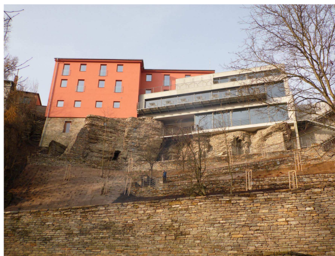
Tentýž úsek po dokončení (12/2013)
