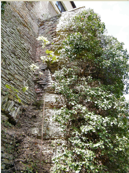
Skalní pilíř P2a a po stabilizaci kotvenou žb vzpěrou s kamennou obezdívkou (2013)
