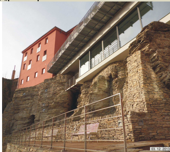
Tentýž úsek po dokončení (12/2013)
