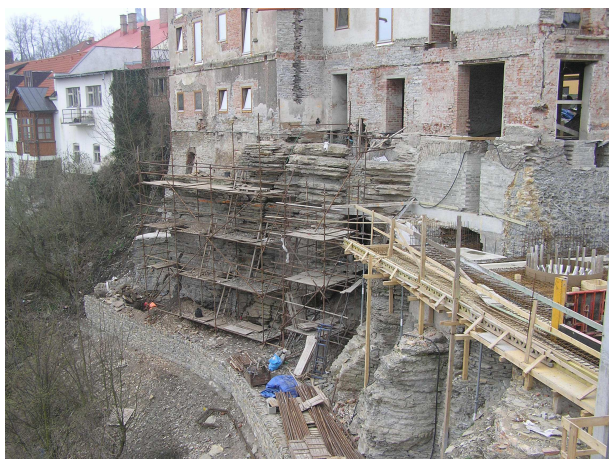
Statická stabilizace skal.stěny pod obj.“B” v 04/2013
